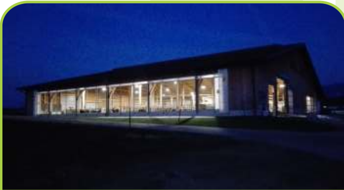
Kundensituation Neubau Lösung mit Rund- und Langfeldleuchten
