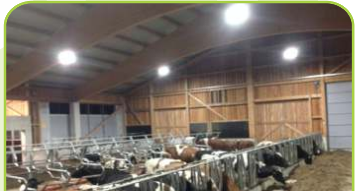
Kundensituation Teilumbau mit Neubau 80W Rundleuchten & Lichtmanagement
